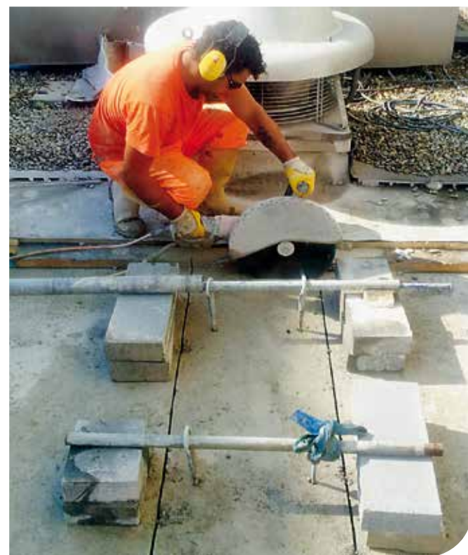
Tecnica di taglio per aperture di lucernai
