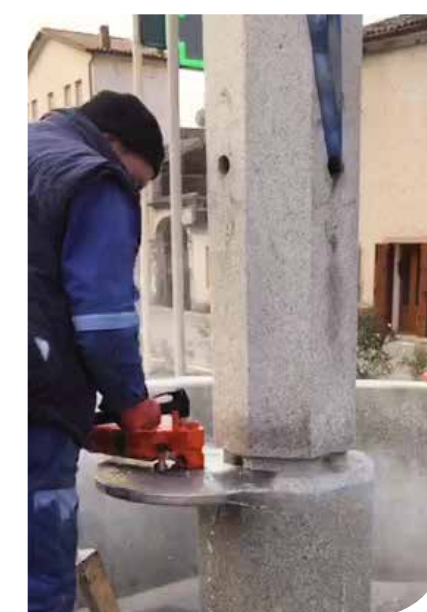
Tagli di pilastri fortemente armati
