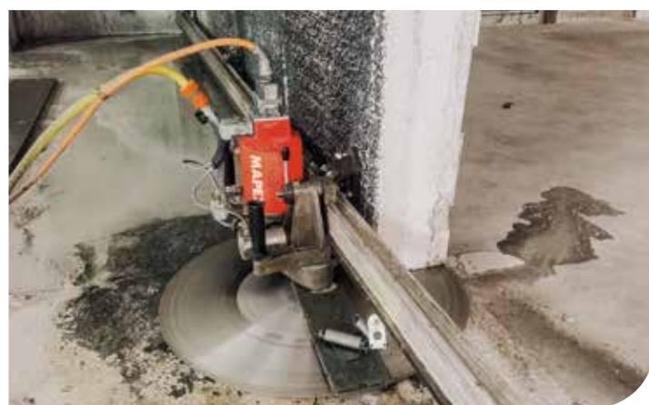
Tagli filo pavimento, per aperture e modifiche di pareti
