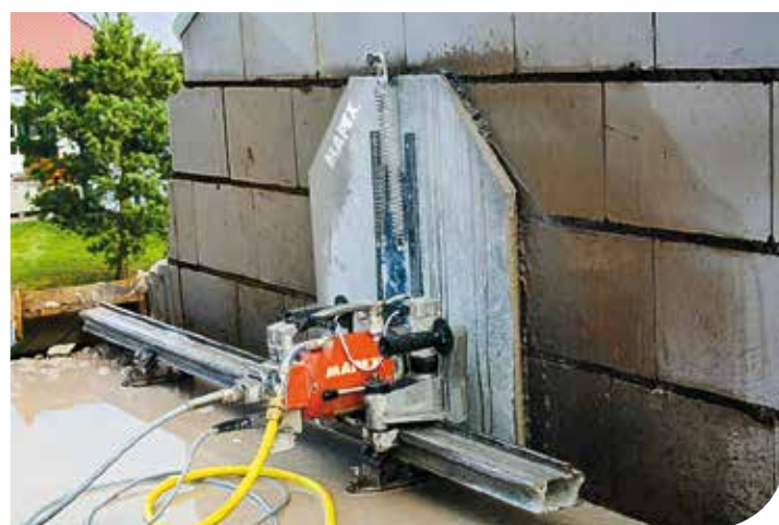
Tagli a filo raso muro con appositi semicaratteri aperti per dischi Ø 745 - 900 mm, verticali, orizzontali, obliqui.
