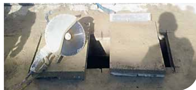
Tecnica di taglio per aperture di lucernai
