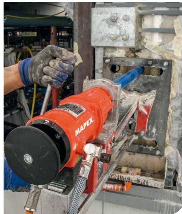
HD 18: sistema di carotaggio ad alta velocità di pilastri per l'inserimento di ammortizzatori antisismici
