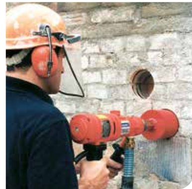
Fori per passaggio di tubazioni
