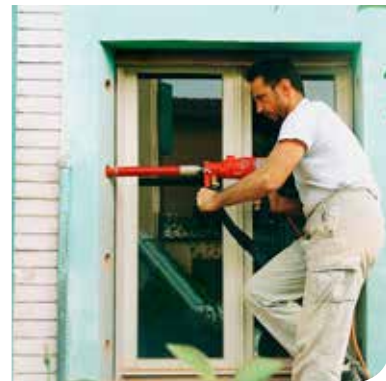
Fori per installazione di inferriate
