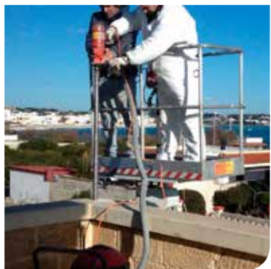
Fori per installazione di copertura
